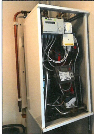
Undercentral / fjärrvärmväxlare hushåll
